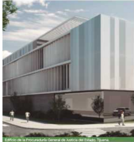
Edificio de la Procuraduría General de Justicia del Estado, Tijuana.
